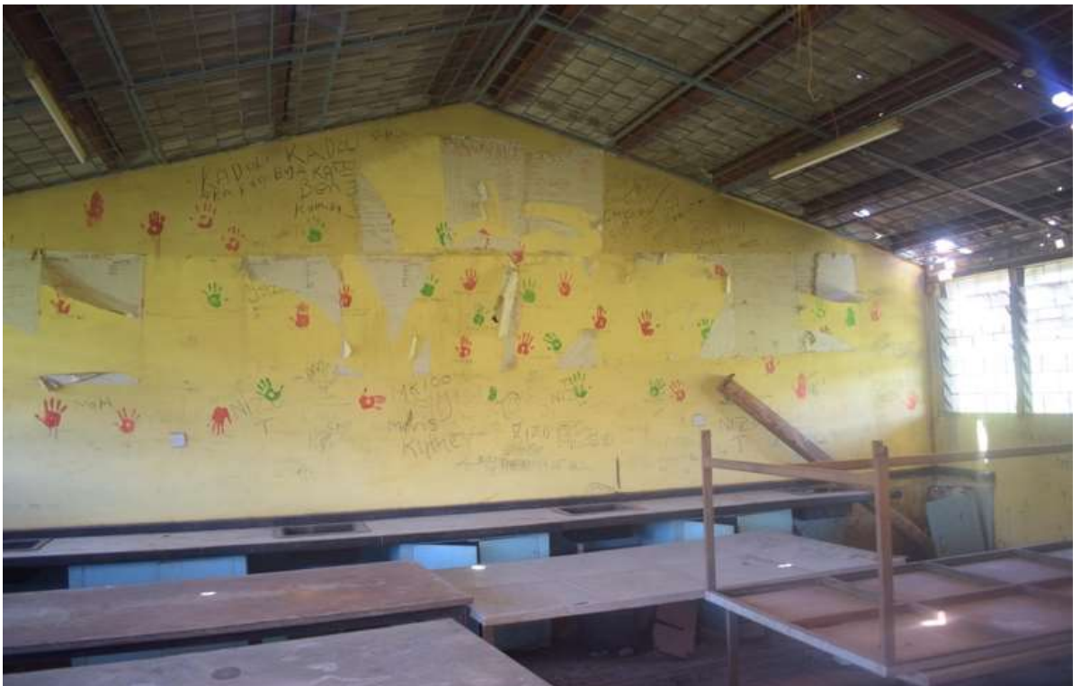
Das Klassenzimmer für die Solartechnikausbildung in Kabete wurde 1912 gebaut und ist heute renovationsbedürftig. @ Abigael Kelvin
